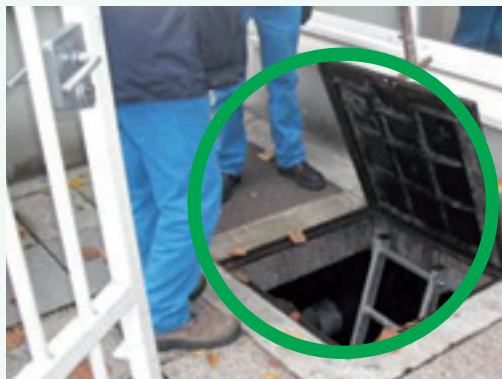
Plaque équipée d'un système d'ouverture adéquat
