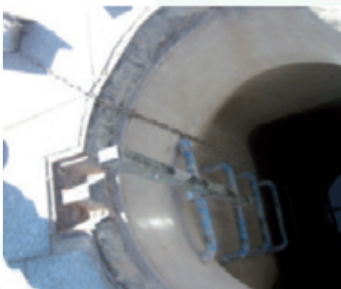
Régulateur accessible par une chaînette d'extraction depuis un regard dégagé et sécurisé
